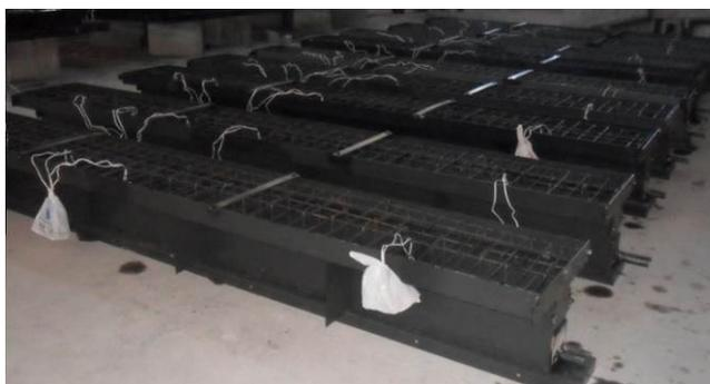
Figura 3.31 - Preparação das formas e armaduras para concretagem
