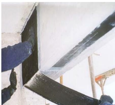
Figura 2.21 - Ancoragem transversal do PRF (Boletim 14 *fib*, 2001)
