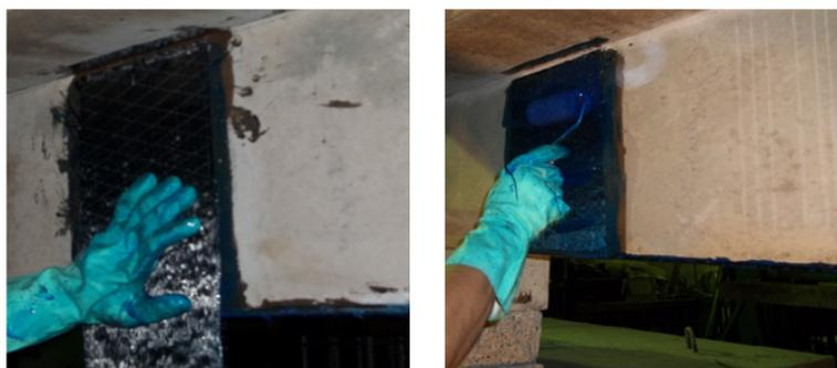
Figura 3.38 - Processo de ancoragem do reforço com PRFC
