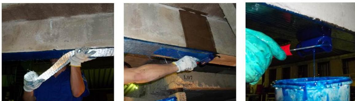
(a) Aplicação da manta      (b) Impregnação com rolo      (c) Aplicação do saturante
