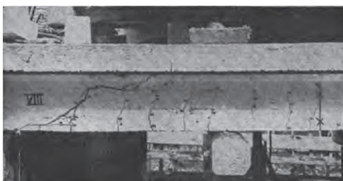
Figura 2.1 - Ensaio de vigas “T” (Mörsch, 1908)
