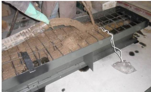
Figura 3.33 - Concretagem e vibração do concreto
