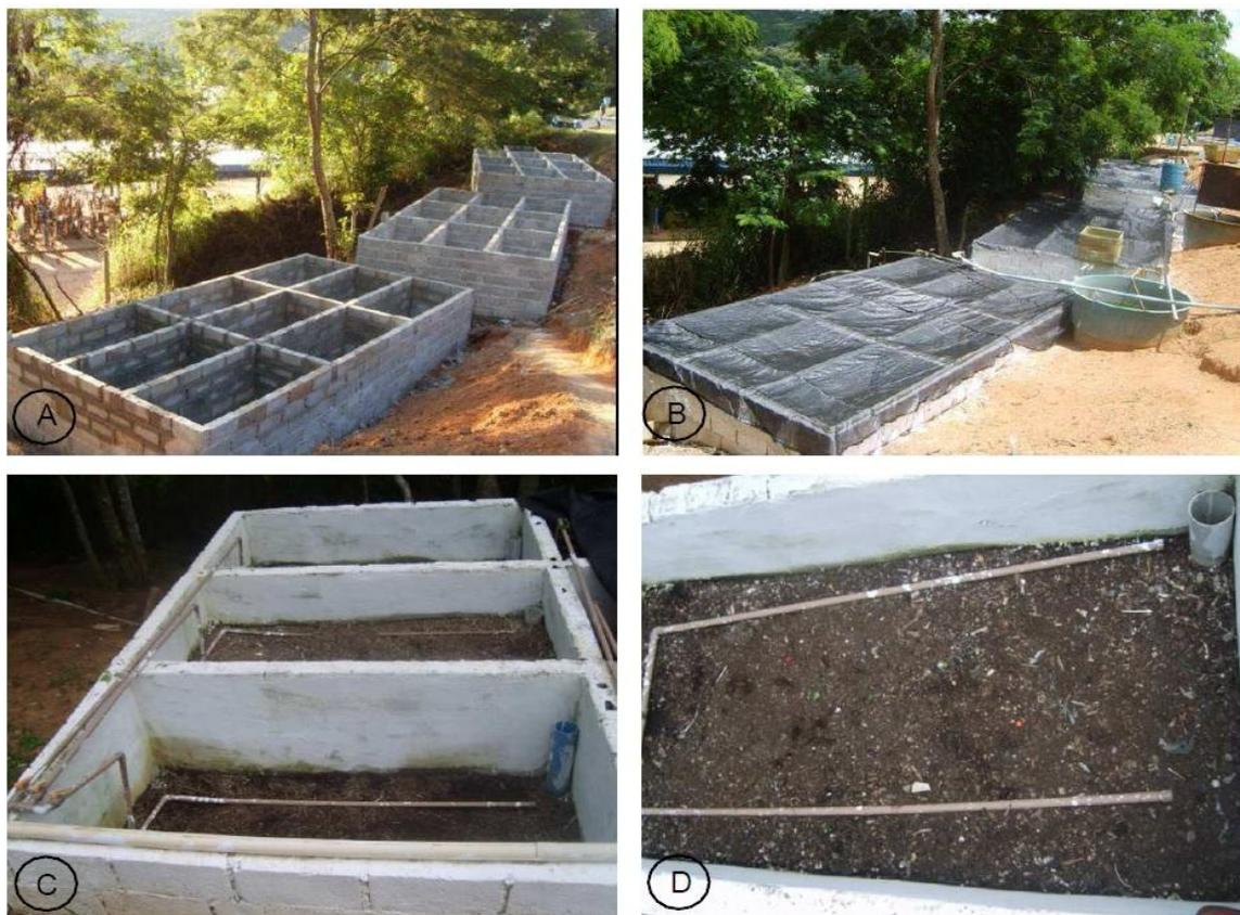
Figura 3.15- Protótipos construído em alvenaria. (a) Processo de construção dos 27 protótipos; (b) Visão dos protótipos já em funcionamento; (c) Os protótipos com a matéria orgânica; (d) Tubulação que alimenta o sistema, (Sartori, 2010).
