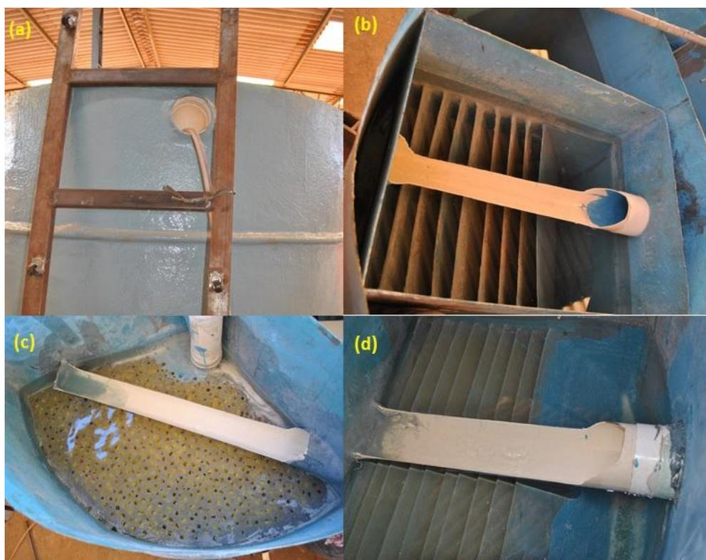
Figura 5.12- Teste da estação compacta. (a) Entrada da água na estação; (b) Saída da água na câmara 1; (c) Saída da água na câmara 2; e (d) Saída da água na câmara 3.
