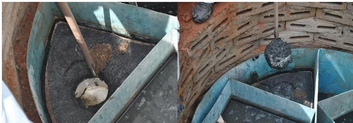
Figura 5.19- Retirada da espuma da Câmara.
