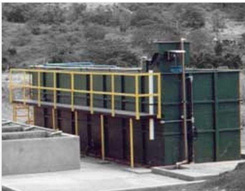
Figura 3.25- Estação compacta de lodos ativados (Tecnosan, 2012).
