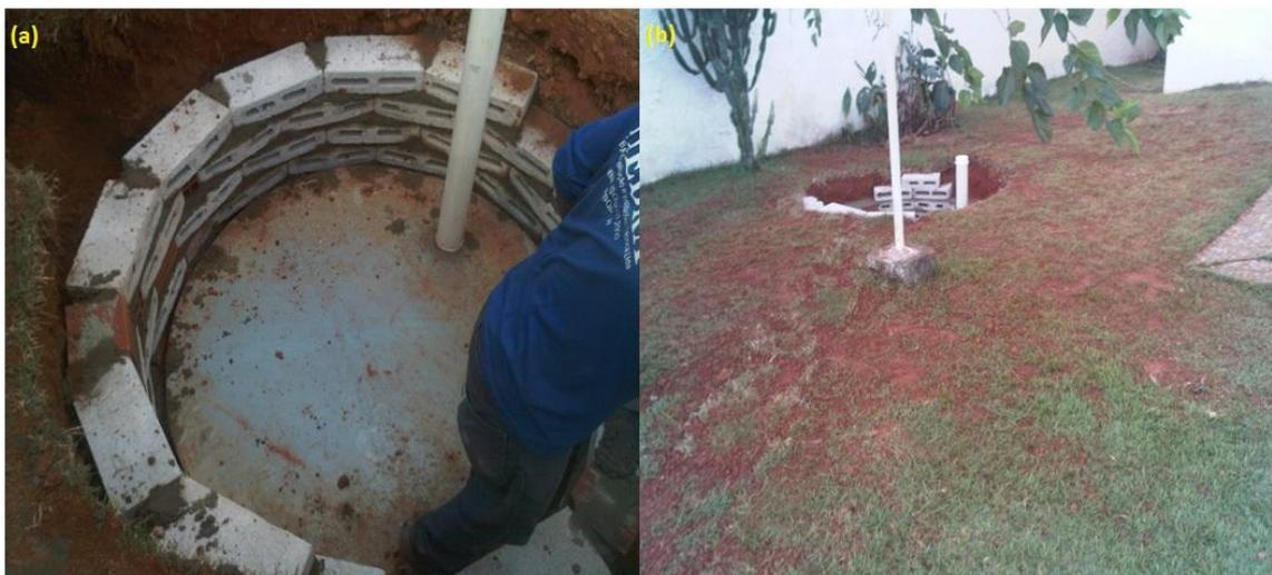
Figura 5.16– Fase de acabamento da instalação, (a) Construção do anel de tijolos de concreto ao redor do protótipo, (b)replântio da grama que foi retirada.
