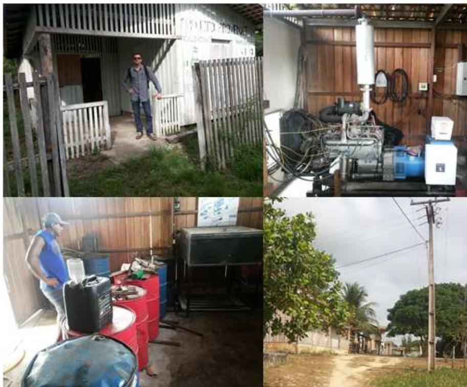
Figura 3.14 – Em sentido horário: casa de geração (no alto à esquerda), gerador, rede de distribuição da comunidade e estoque de óleo de palma.
