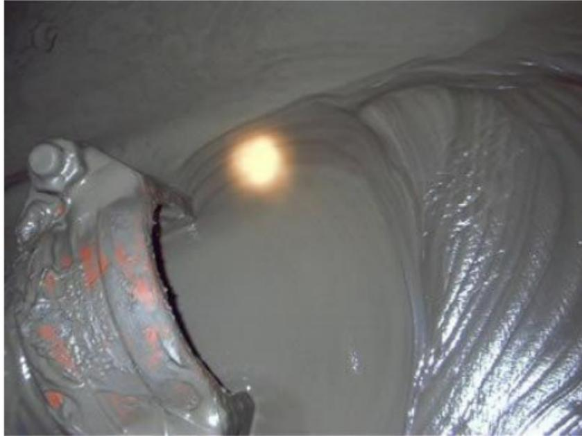
Figura 2.4 – Consistência típica do *backfill*.
