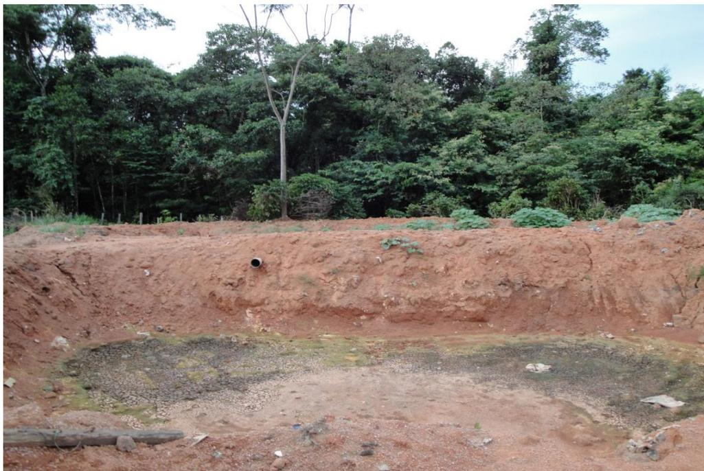
Figura 25 Trincheira sem impermeabilização do solo. 2009
