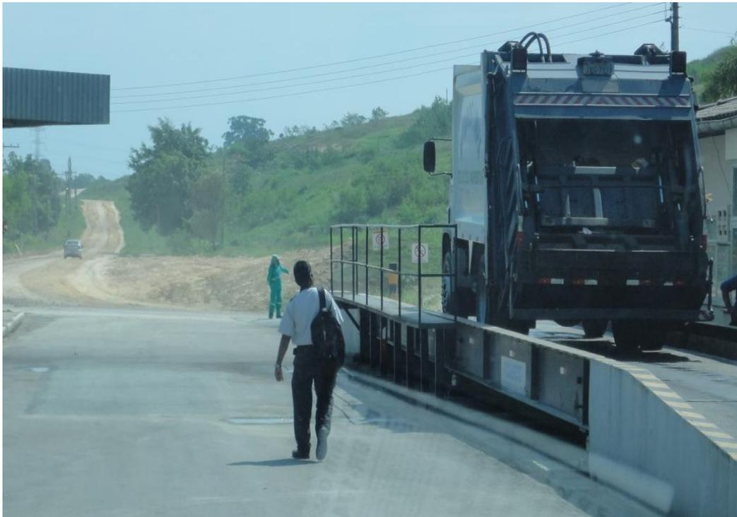
Figura 58 Balança na entrada do aterro de Manaus. 2012
