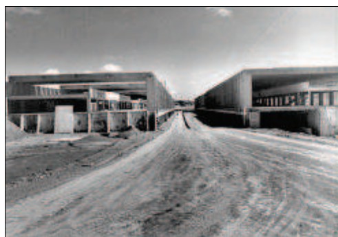
Figura 43: Construção do Minhocão, principal prédio da UnB.
