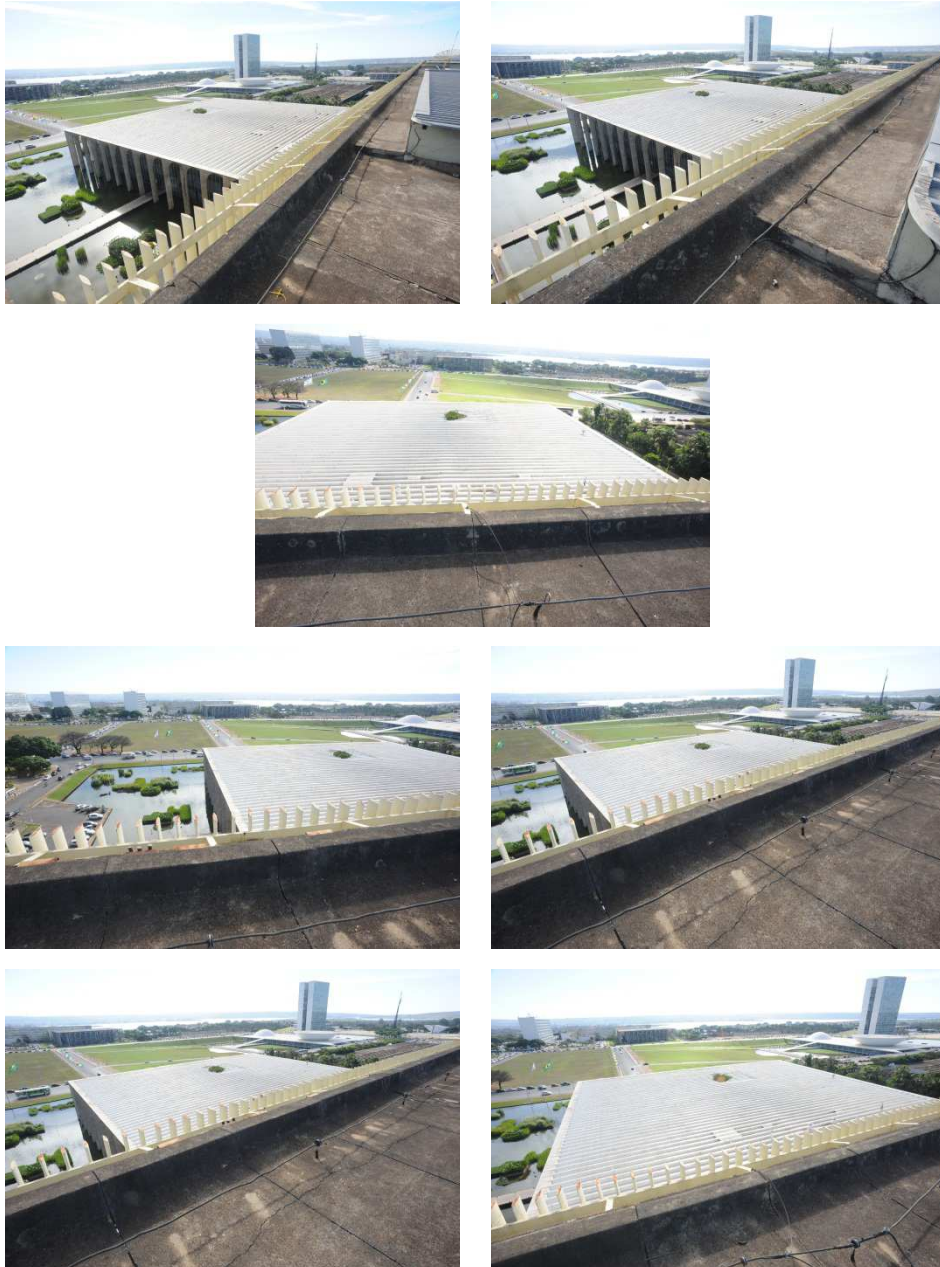
Figura 4. 16 - Fotos da cobertura
