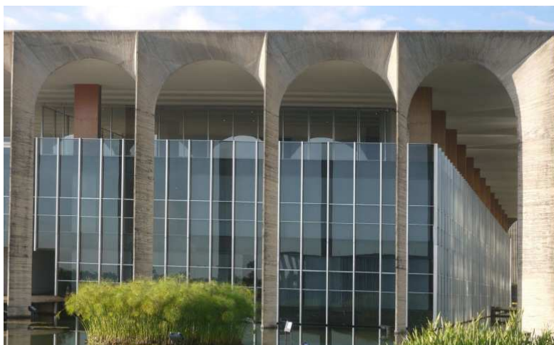
Figura 4. 4- Fachada principal pilares externos e internos
