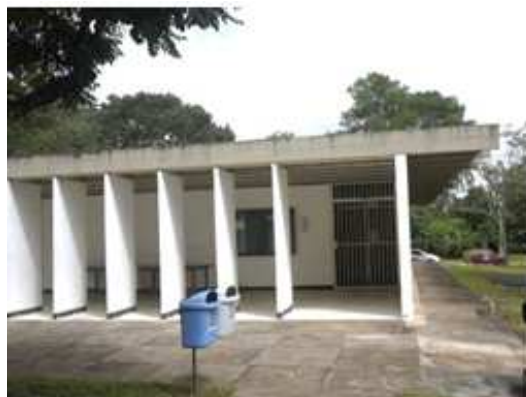
Figura 3. 24- Fotografias tomadas para a Fachada Principal
