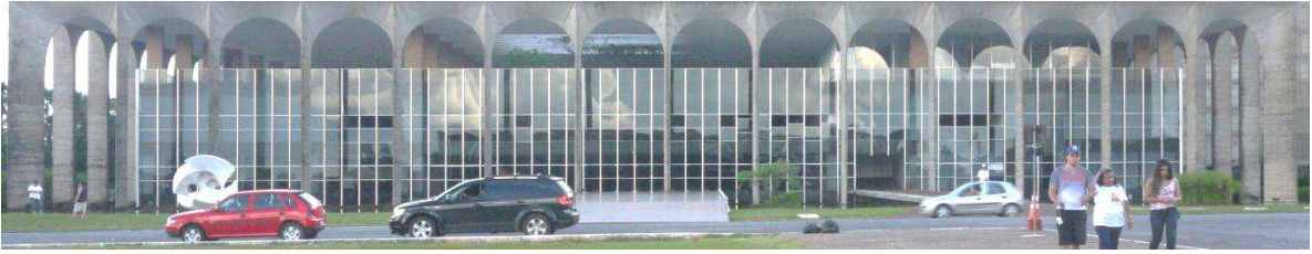
Figura 4. 2 - Fachada Principal Palácio Itamaraty. Foto da autora (2012).
