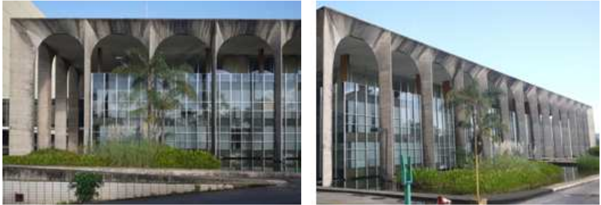
Figura 4. 9 - Presença de vegetação Zona III
