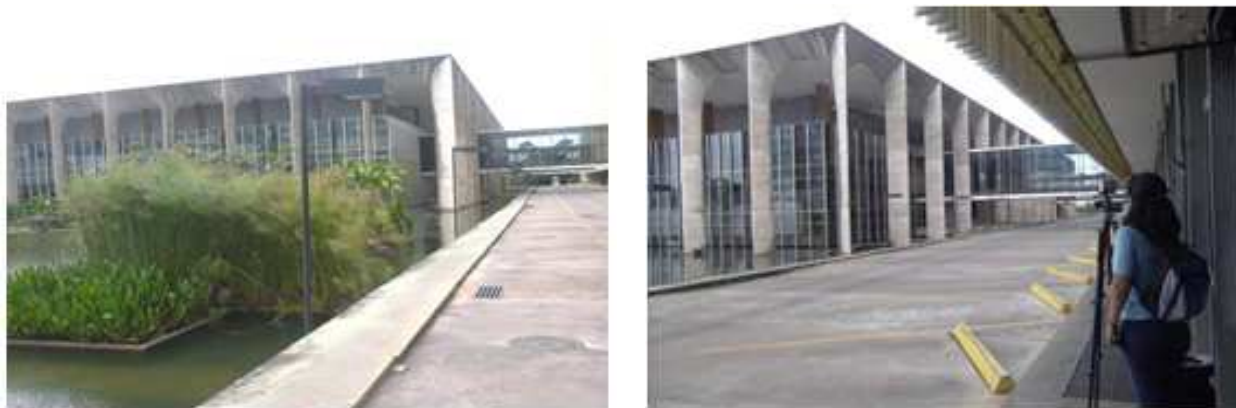
Figura 4. 6 - Distância insuficiente câmara - fachada C
