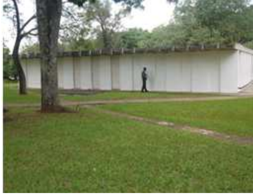
Figura 3. 25- Fotografias tomadas para a Fachada Esquerda
