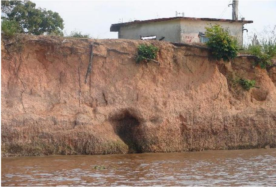
Figura 14: Buraco na margem da cidade de Parintins, provocado pelo solapamento de banzeiro do vento com contribuição dos barcos.
