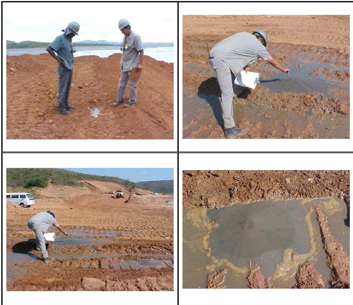
**Figura 5.3:** Registro fotográfico da formação do “vulcão” por causa do fluxo de água.
