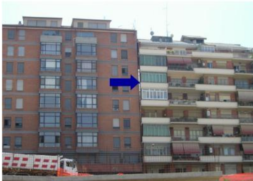
Figura 2.18 - Recalque diferencial observado entre edifícios residenciais (Raspa et al. , 2008).
