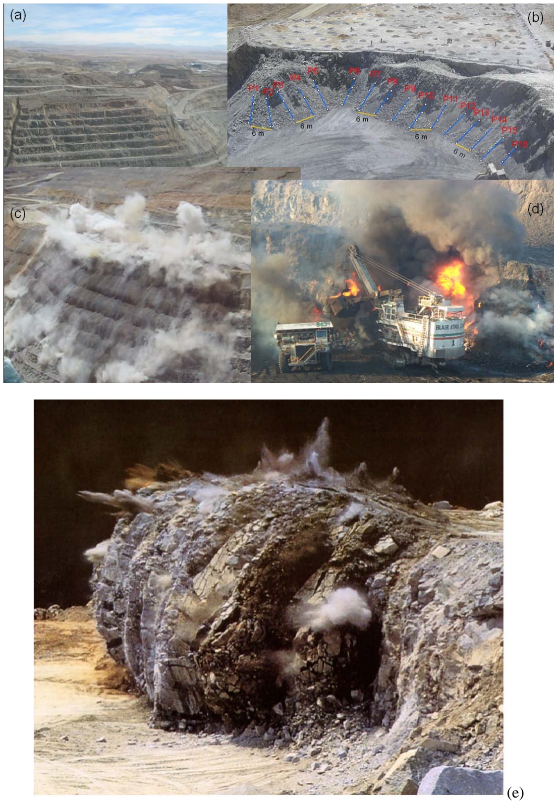
Figura 6.3 – Processo evolutivo de construção de taludes (a) bancadas antes da escavação (b) plano a fogo (c) detonação (d) escavação mecânica (e) dano ao talude.
