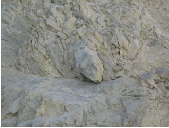
Figura 5.32 – Blocos instáveis na face do talude de bancada.
