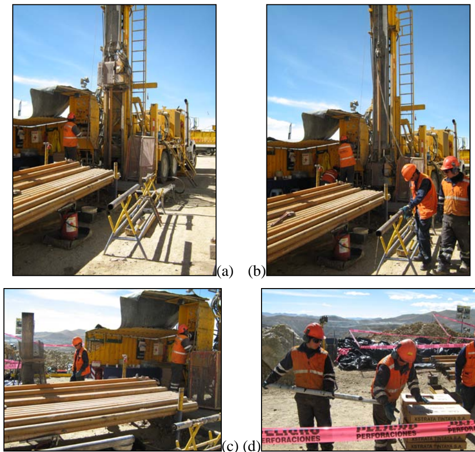
Figura 5.2 – Campanha de perfuração geotécnica nos maciços rochosos estudados: a) máquina perfuradora Diamec CS3000; b) procedimento de sondagem; c) barrilete duplo tipo HQ; d) armazenamento.
