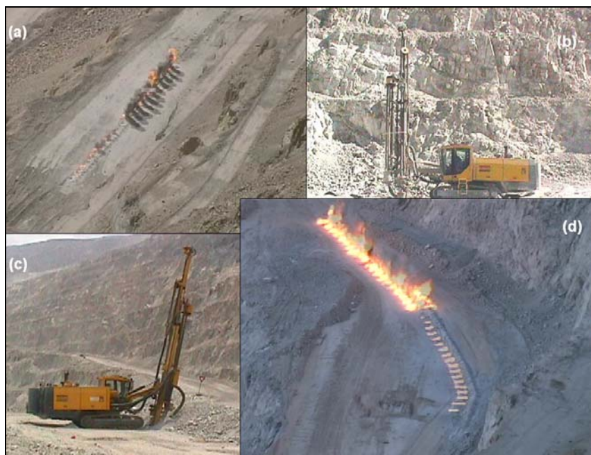
Figura 2.31 – Técnica do pré corte para evitar dano nas paredes pela detonação de furos de produção (a) detonação do pré corte em fases sem confinamento ou de face livre (b) perfuração dos furos verticais de pré corte com 5” de diâmetro (c) perfuração dos furos inclinados (65°) de pré corte com 5” (d) início de detonação do pré corte com retardamento.
