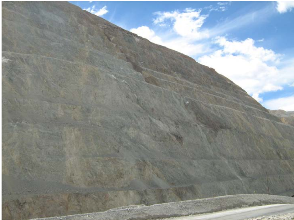
Figura 5.36 – Redução da largura da plataforma superior da bancada pela ocorrência de deslizamentos.
