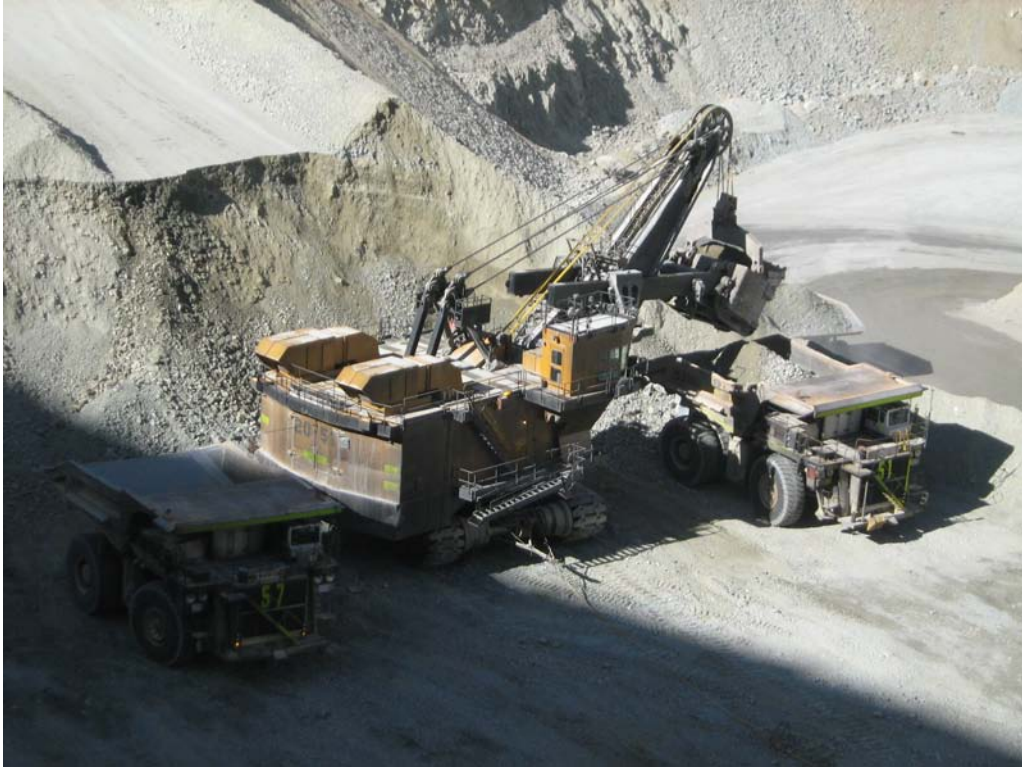
Figura 5.35 – Escavação mecânica de equipamentos de grande escala.
