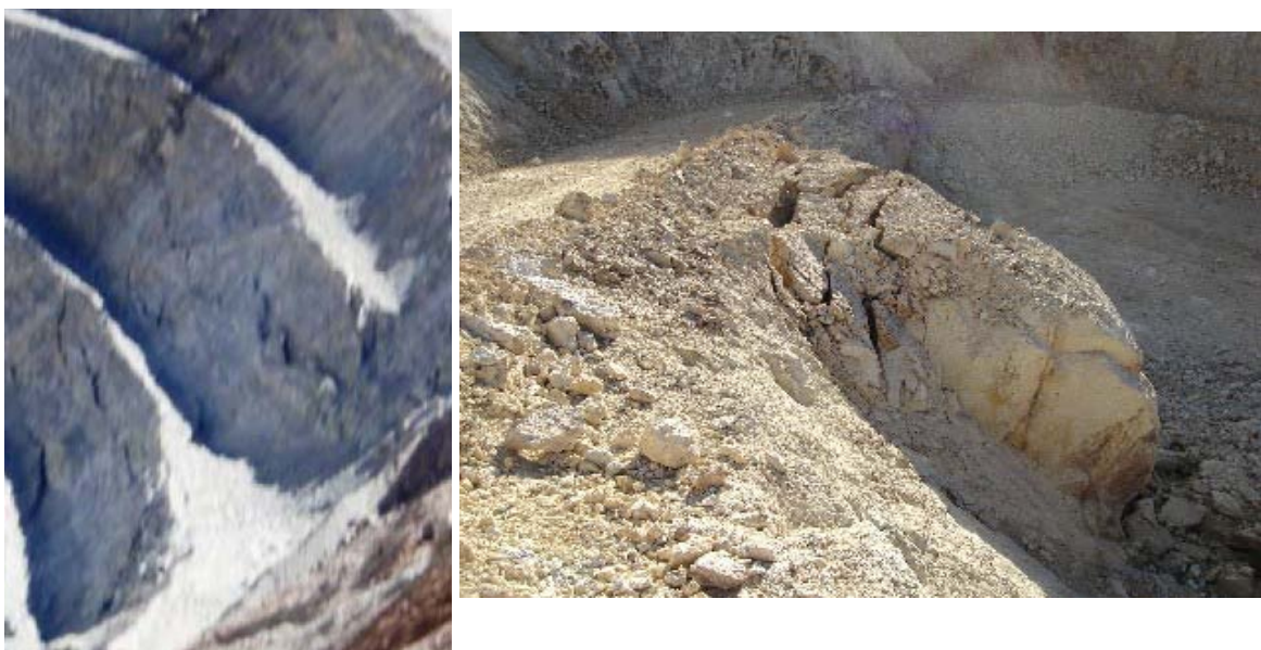
Figura 5.39 – Mecanismo de ruptura por tombamento.
