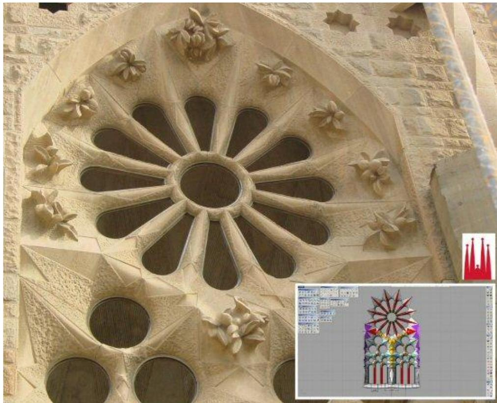
Figura 29 – Elemento paramétrico e sua construção da Sagrada Família de Gaudí.
