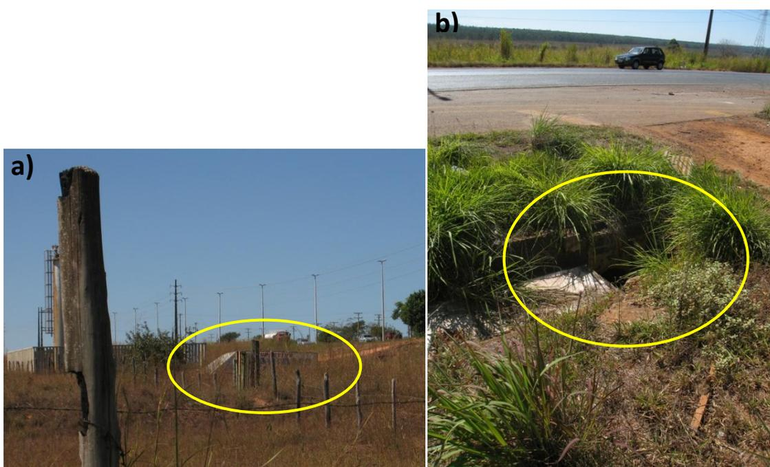
Figura 5.28 – Foto a) mostra o detalhe da Figura 5.27b em campo; foto b) apresenta estrutura de coleta de águas pluviais que fica no canteiro central da BR-070, similar ao do detalhe na Figura 5.27a.
