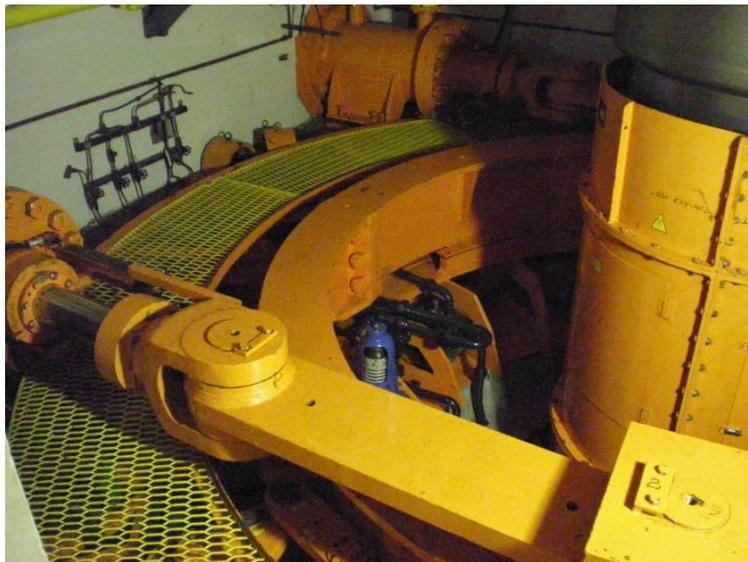
Figura 2.10: Servomotores do anel distribuidor
